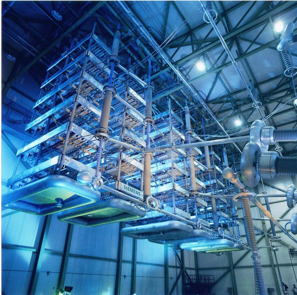
**Bild 2.38** Aufbau der Ventilhalle für eine 12-pulsige Stromrichtergruppe
